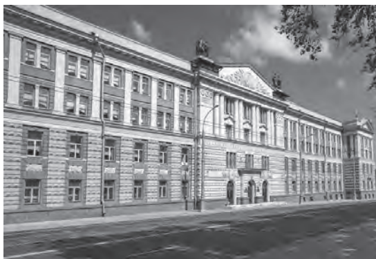
Рис. 14. Здание Минского суворовского училища
